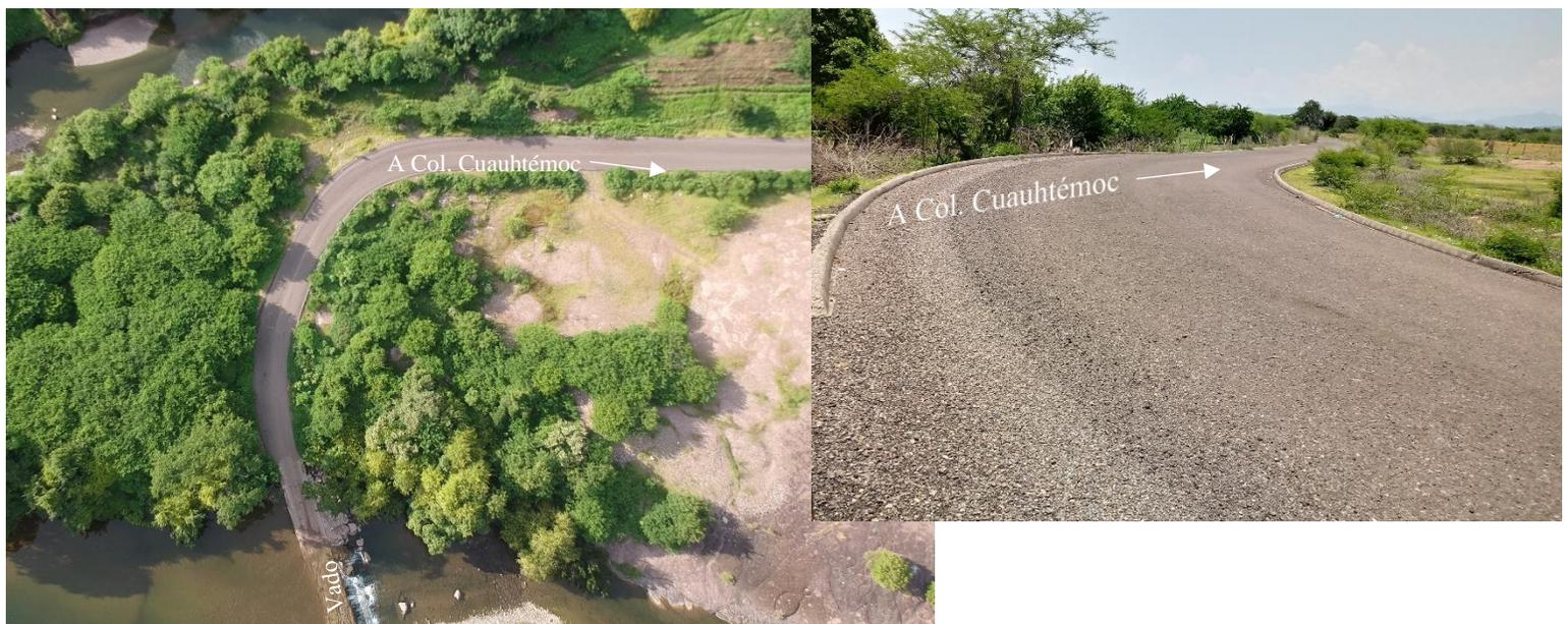
*Imagen 8. Fotografía aérea y terrestre de noreste a este del vado en la cual se observa el camino existente revestido con concreto asfáltico el cual comunica a las localidades de Tlalchapa con Cuauhtémoc.*
