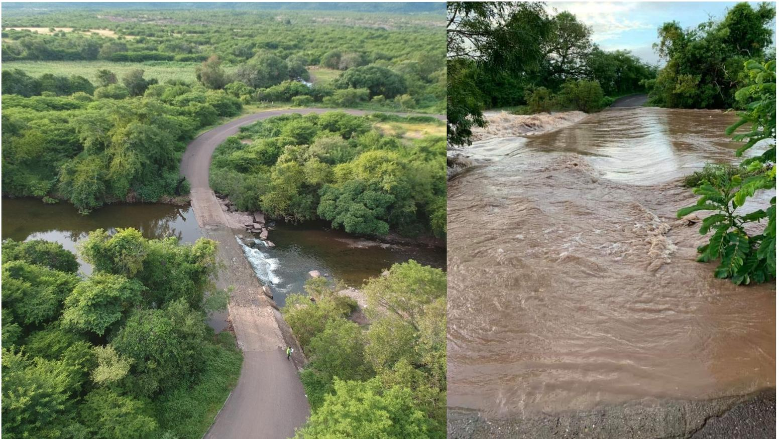
Fotografía 8 y 9. Vista área tipo frontal de sur a norte del vado existente y un ligero aforo de agua que permite los desplazamientos de los habitantes; la fotografía izquierda muestra el vado tras una crecida suscitada en el mes de septiembre de 2019 el cual imposibilita el desplazamiento seguro de las personas.
