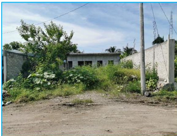
Fotografía II.3 Se observa la barda perimetral del polígono.
