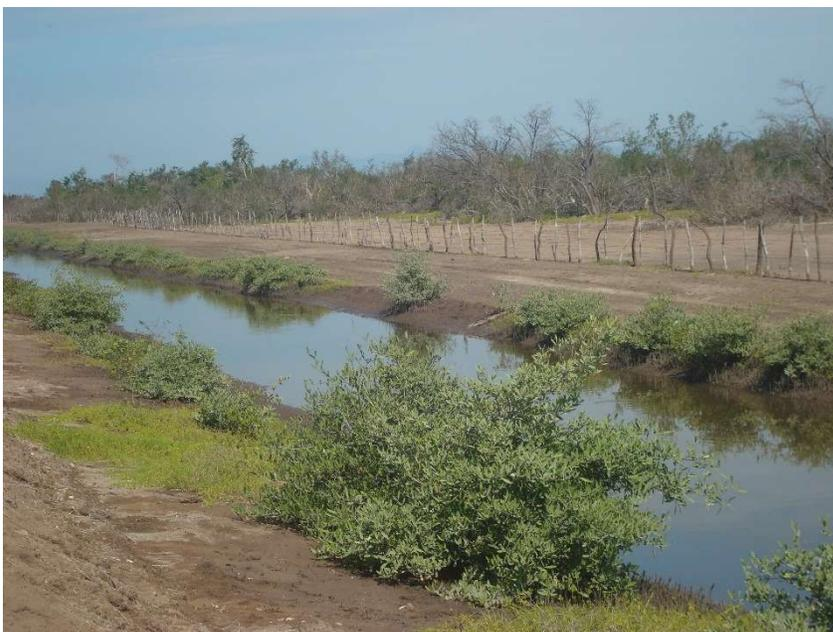
Tramo del Dren de descarga del estanque 1 de la granja Chalpeña 1, se observa incipiente vegetación halófila sobre el talud, por lo que se prevé el establecimiento inducido con mangle para estabilizar y conservación del talud del dren y aporte al hábitat de especies silvestres.
