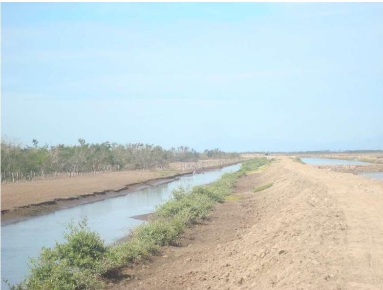
Izquierda, el cuerpo de agua existente corresponde a canal de llamada de la granja, polígono Chalpeña 3, se aprecian bordería, reservorio, al centro al fondo se observa el cárcamo de bombeo, en la margen derecha del canal de llamada y talud se desarrolla parcialmente vegetación halófila vidrillo, puyeque.
