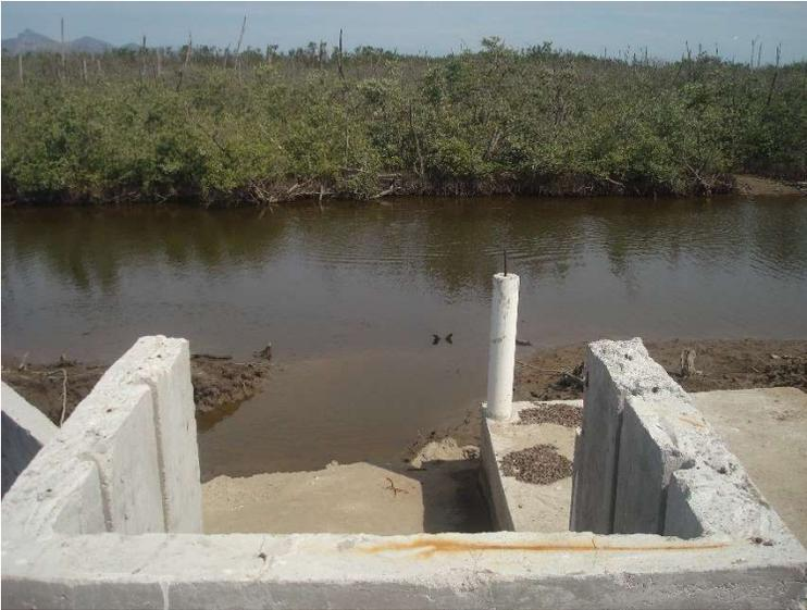
Compuerta de salida de un estanque de la granja Chalpeña 2, descarga a un dren de descarga que se localiza en terrenos del área de influencia de la Laguna El Guayabo.
