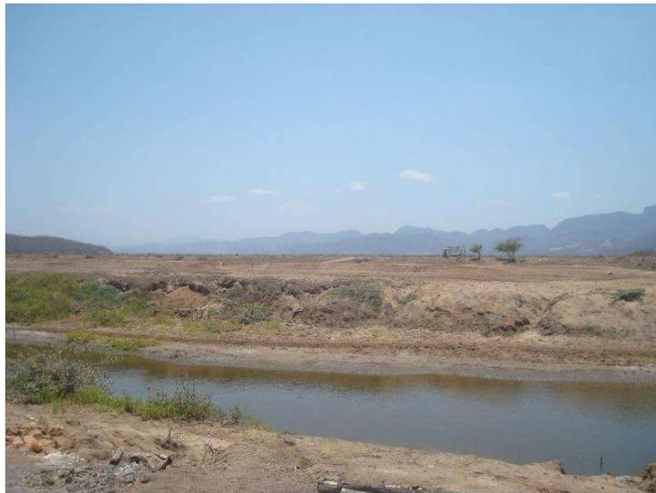
Tramo del Dren de descarga del estanque 1 de la granja, se observa incipiente vegetación halófila sobre el talud, por lo que se prevé el establecimiento inducido con mangle para estabilizar y conservación del talud del dren y aporte al hábitat de especies silvestres.
