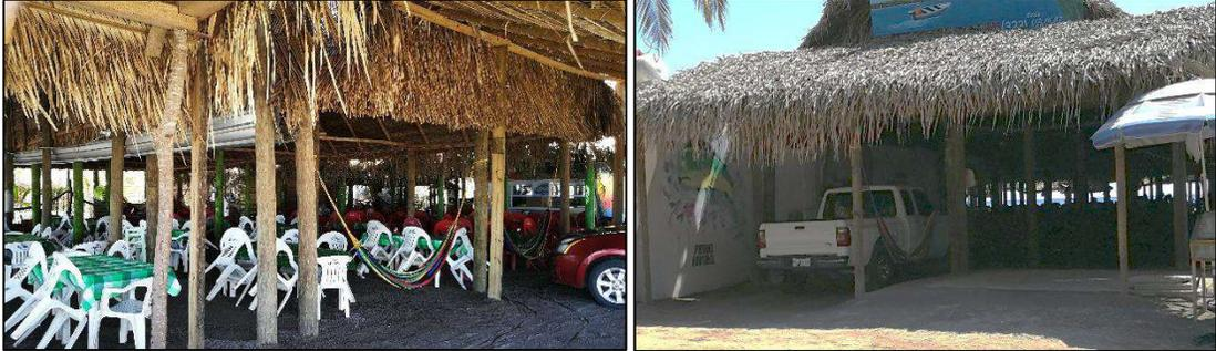
*un barra para bebidas que ocupa una superficie aproximada de 14.44 M2, construida con postes de madera, paredes de madera y techo de palapa y madera;*
