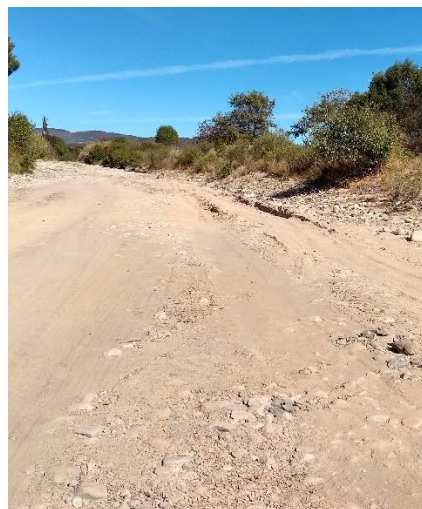
Fotografía 4. Condiciones actuales banco 1
