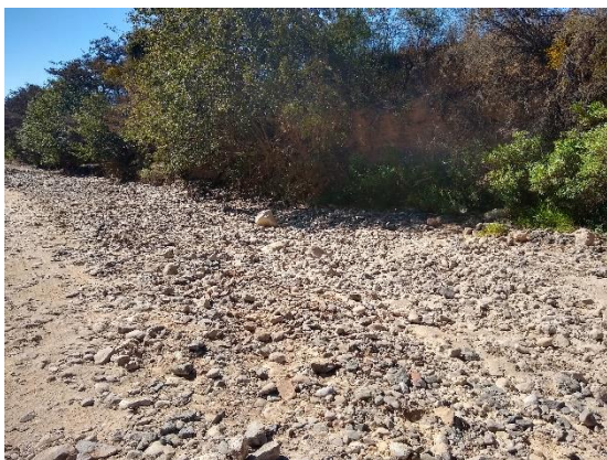
Fotografía 9. Condiciones actuales banco 2
