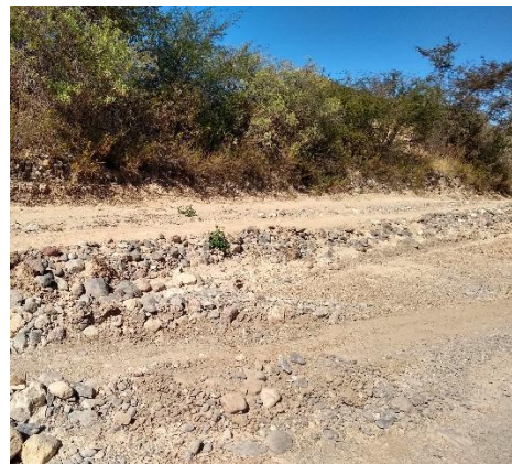
Fotografía 8. Condiciones actuales banco 1.
