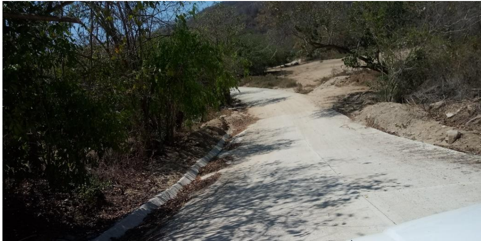
Camino de acceso a Zapotengo (pavimentado con concreto hidráulico)
