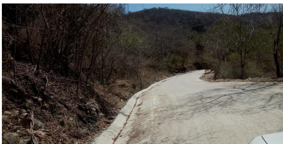
Camino de acceso a Zapotengo (pavimentado con concreto hidráulico)
