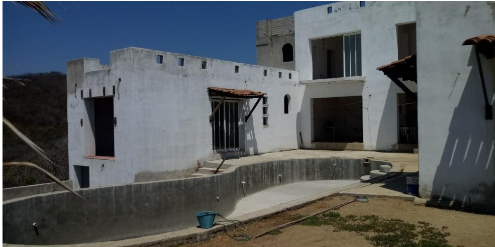
Vista de la villa (fachada)
