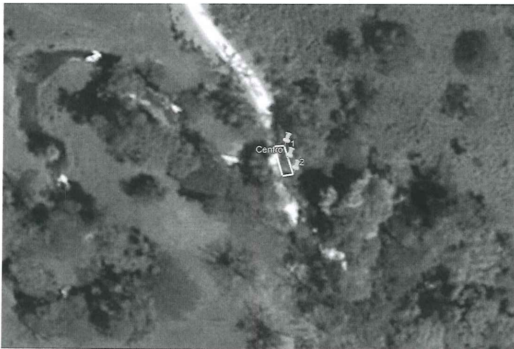
Fig. No. 1.- Se muestra el sitio de construcción del puente y sus condiciones de vegetación
