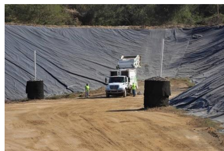
Nueva celda con geomembrana para la disposición final de los residuos
