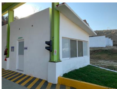
Oficinas administrativas de las nuevas instalaciones
