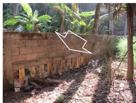
Paso pluvial ubicado en el muro existente en la colindancia suroeste del predio
