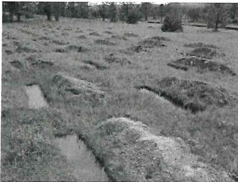
Zanja trinchera (tina ciega)
