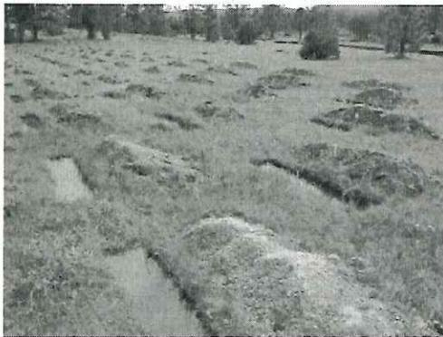
**Zanja trinchera (tina ciega)**
