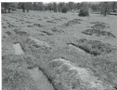
Zanja trinchera (tina ciega)
