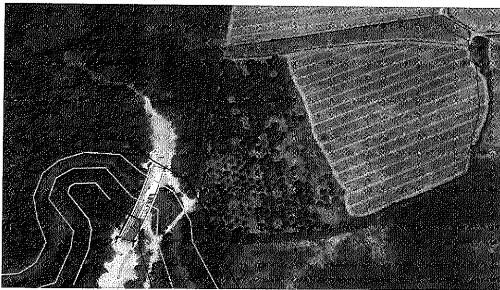
Fracción Sur del proyecto que se traslapa con la Delimitación 2022 de Zona Federal de estero
