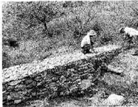
Imagen 27 y 28. Ejemplo del acabado final de las Presas de piedra. La segunda muestra una gran cantidad de azolve retenido.
