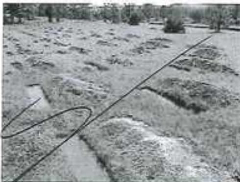
Zanja trinchera (tina ciega)
