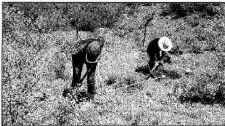
Las terrazas individuales deben tener como mínimo un metro de diámetro y al menos 10 centímetros de profundidad de corte, con taludes estabilizados con materiales disponibles. Estas medidas pueden variar de acuerdo con la pendiente y la profundidad de suelo.
