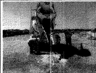
Contaminación de suelo por disposición incorrecta de residuos de mezcla y lavado de ollas.
