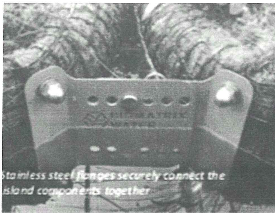
Figura 4 . Imagen de referencia de estructuras de acero para unir módulos.
